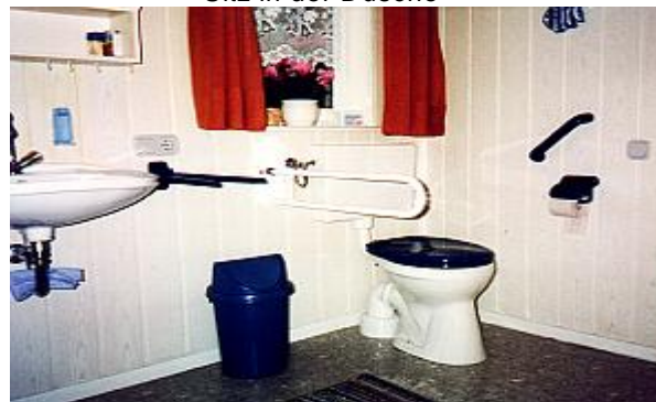
Handgriffe an Dusche und Toilette
